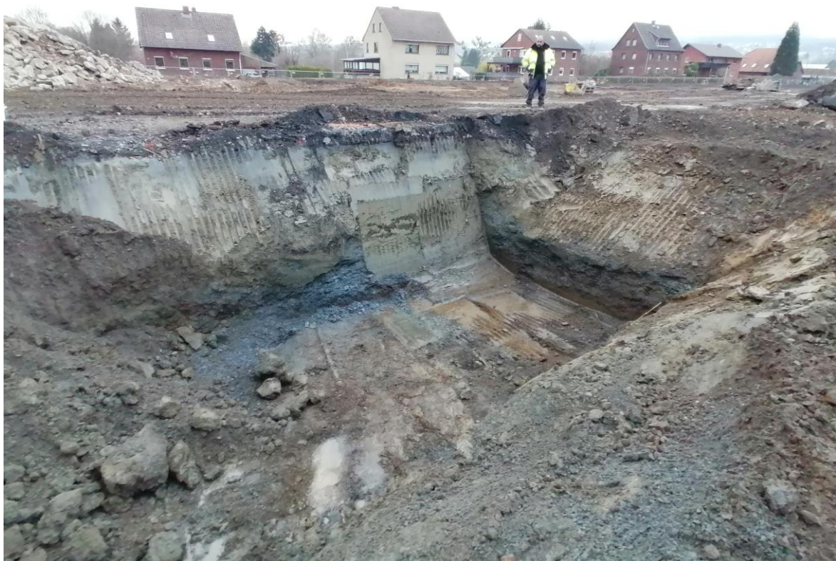
Foto 20: Grube nach weiterer Vergrößerung und Schaffung von Böschungen (Datum: 09.12.2021).
