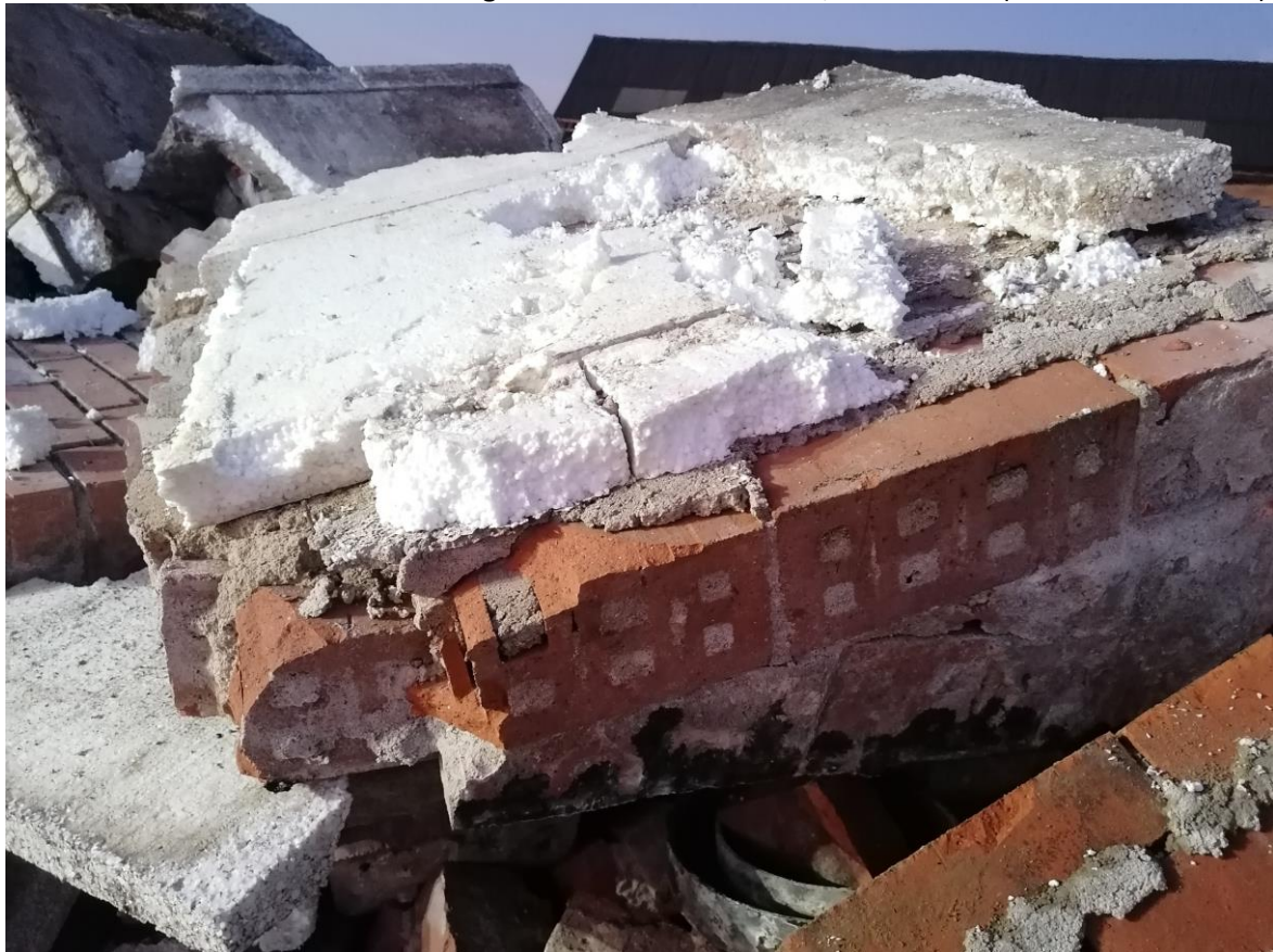
Foto 10: Nahaufnahme des Mauerwerks mit Styroporplatten, Gebäude 15 (Datum: 09.11.2021).
