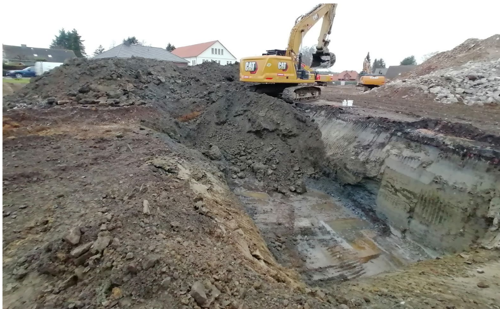
Abbildung 2: Aushub von MKW-belastetem Bodenmaterial aus der Grube im Bereich der ehem. Eigenbedarfstankstelle auf dem Grundstück des ehem. Sägewerk Möller (Dezember 2021; Oben: Blick nach Norden; Unten: Blick nach Nordwesten).
