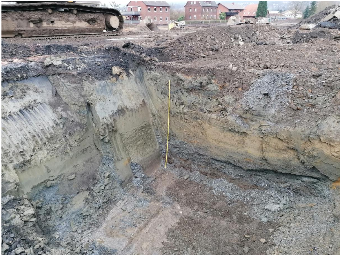
Foto 19: Freilegung der Grubensohle unterhalb des belasteten Tonsteins (Datum: 09.12.2021).
