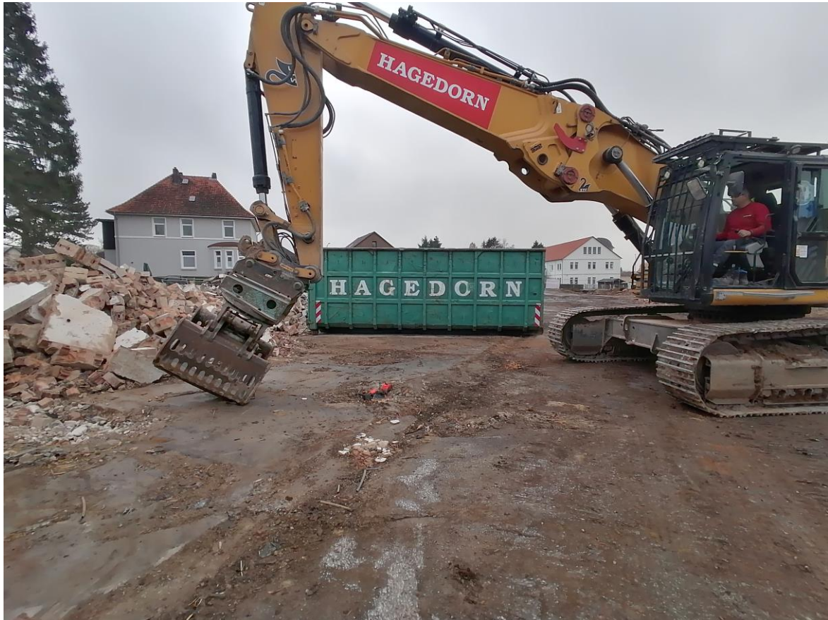
Foto 11: Aufbrechen des Betonfundaments der Garage/Gebäude 13 (Datum: 17.11.2021).
