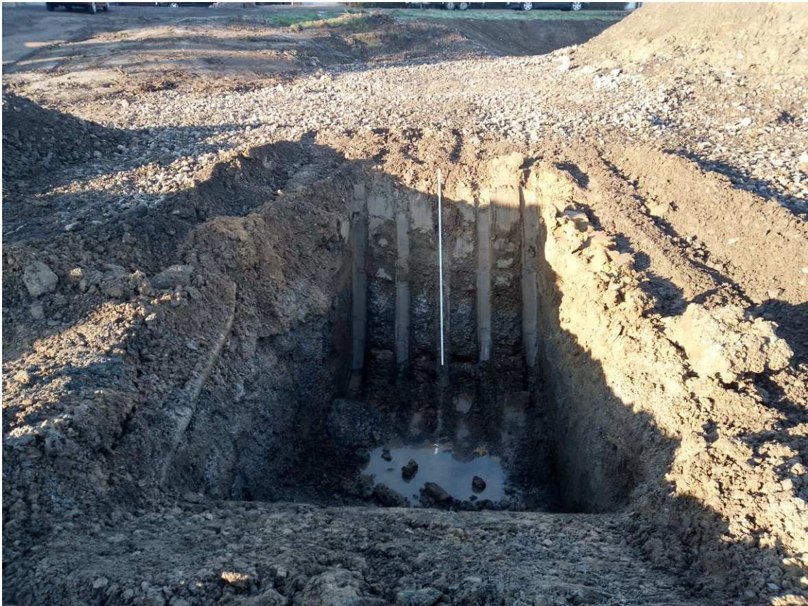
Foto 27: Baggerschurf BS1 zur südlichen Abgrenzung des MKW-Schadens (Datum: 11.01.2022).
