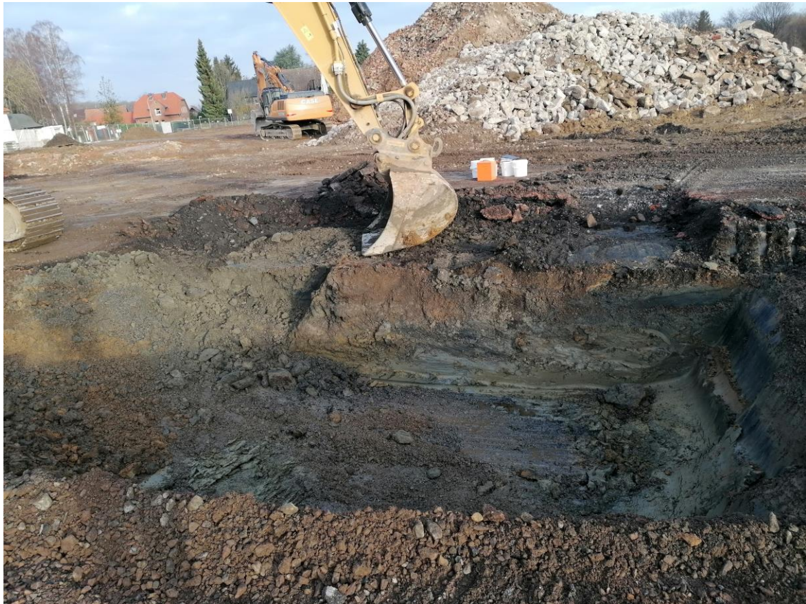
Foto 17: Aushub der flachen Bodenverunreinigung bei der ehem. Tankstelle (Datum: 09.12.2021).
