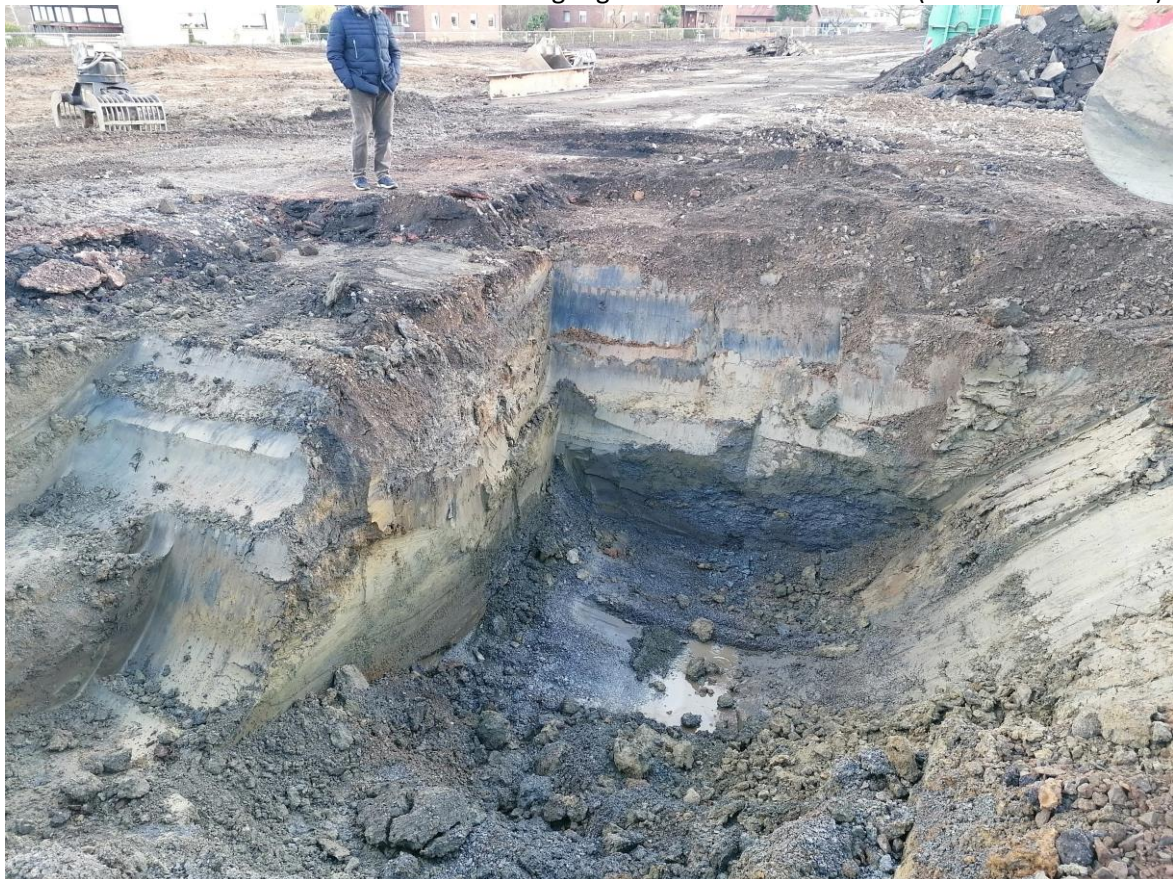
Foto 18: Freilegung und Entfernung des tieferen MKW-Schadens im Tonstein (Datum: 09.12.2021).
